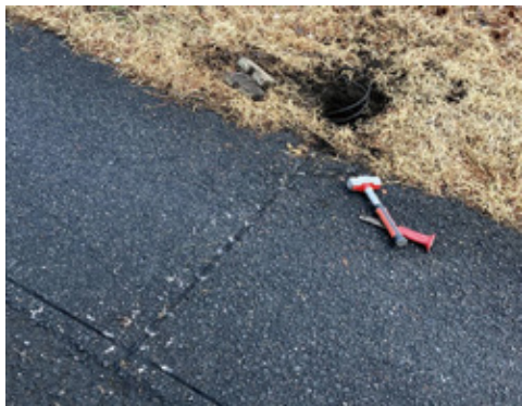
点検升点検中
